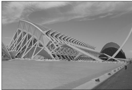
Figure 5.3: Test image: Ciudad de las Artes y las Ciencias, Valencia, Spain (source: W. Daems)
